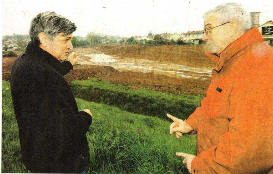
Jean-Claude Planès (à gauche) et Daniel Auberger sur le chantier du bassin de rétention des crues du Séoux, entre la rocade et les quartiers de Veyrières-Rayssac. Photo DDM, Emilie Cayre
